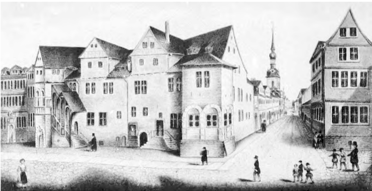
Wolfenbüttel, ehemalige Kanzlei, jetzt Braunschweigisches Landesmuseum. 1587/88 Umbau eines Hauses aus dem 2. Viertel des 16. Jh. durch Hans Vredemann de Vries, 1851-53 Umbau durch L. Kubn. Gemälde um 1846 von J. Th. Fr. Helmcke (Ansich von NW). Staatsarchiv WF
